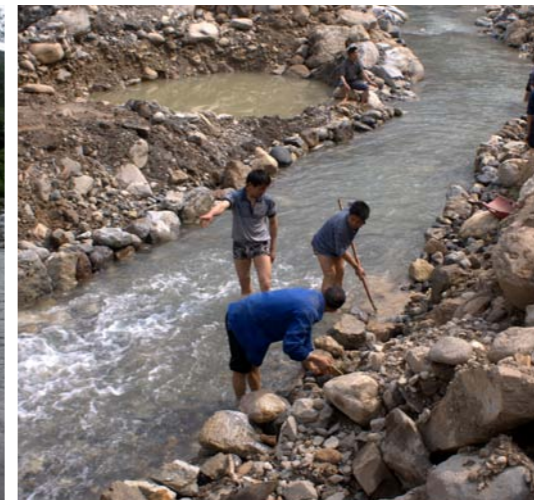
建桥和修路一样，在保证安全的情况下村民也要投劳。
