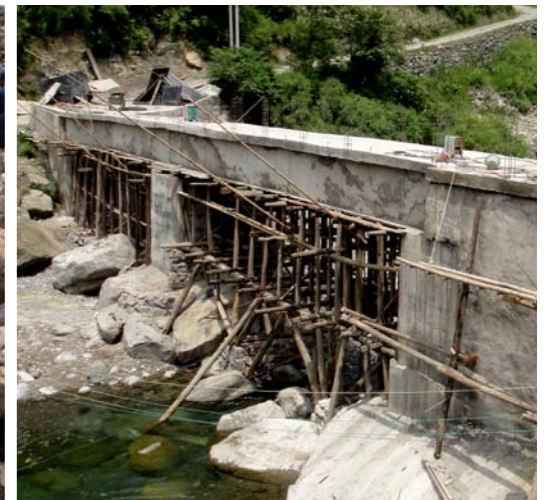
将要竣工的桥。
